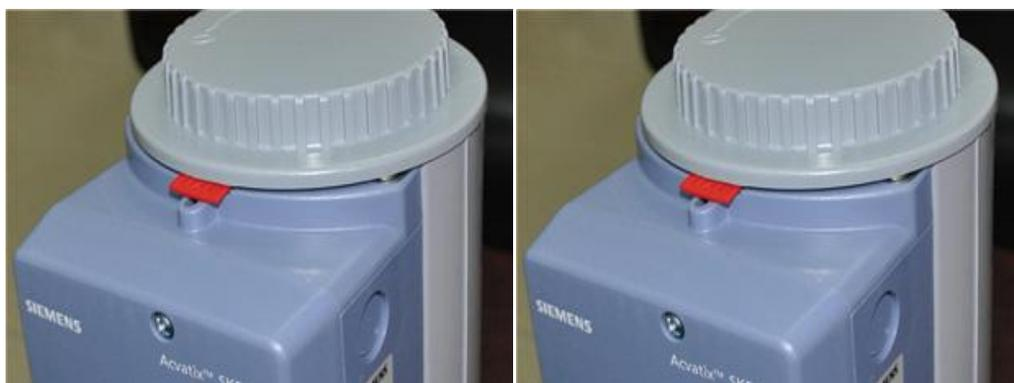
通过旋转上部的旋钮，红色卡片缩进执行器，表示执行器处于自动状态。**安装完毕，必须如下图，下图为正确方式**
